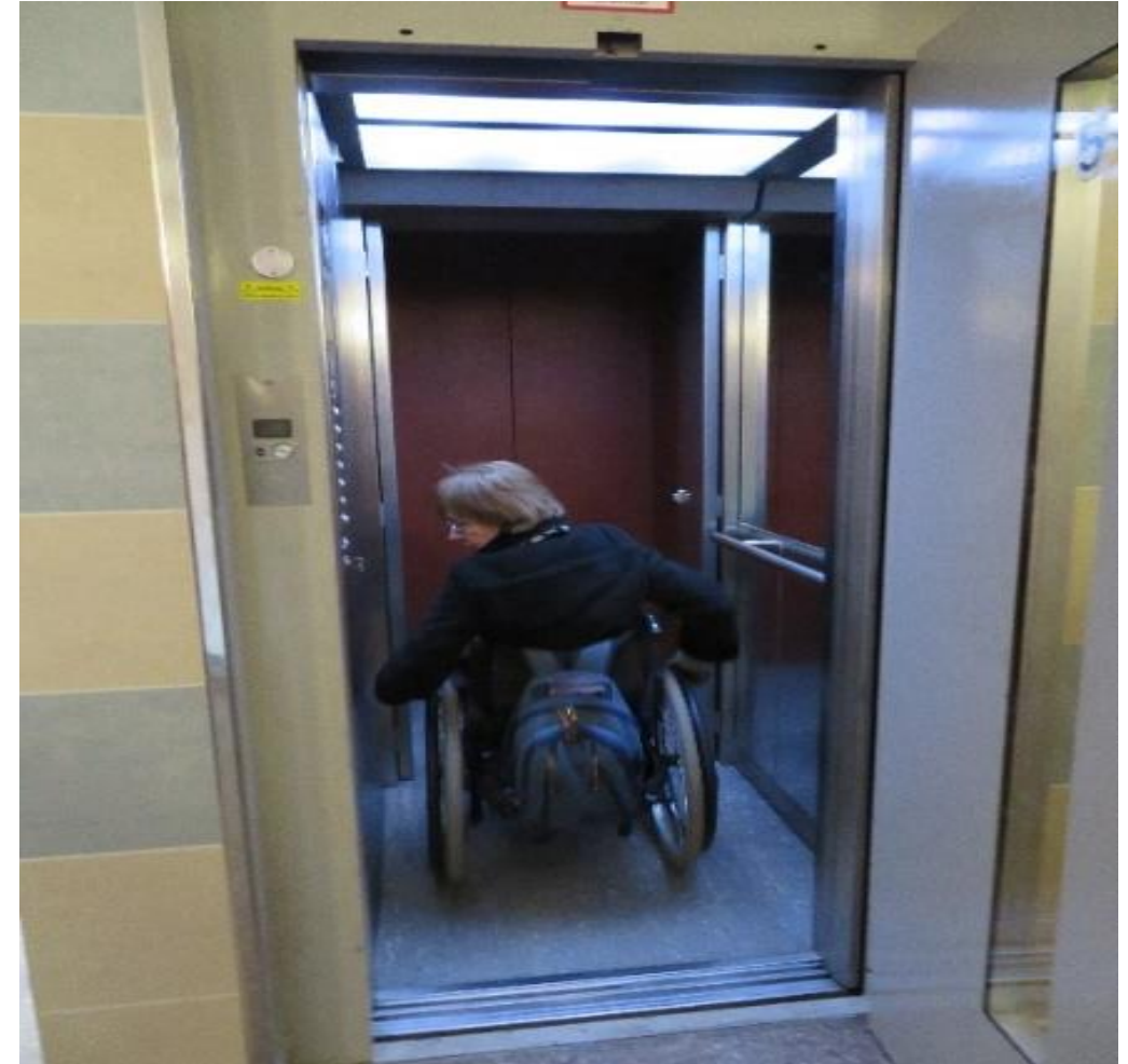
Лифт, доступный для инвалидов (Без зеркала на задней стенке кабины выезд задним ходом вызывает трудности)
