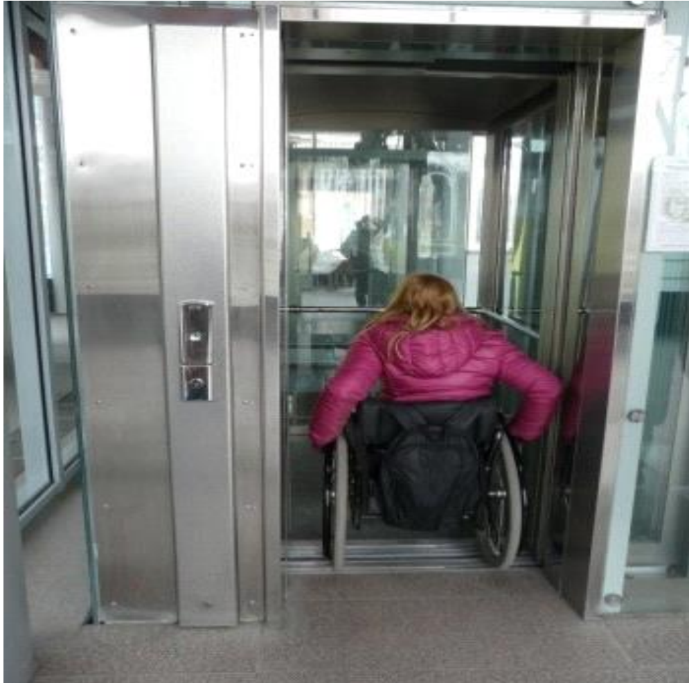
Лифт, доступный для инвалидов (Без зеркала на задней стенке кабины выезд задним ходом вызывает трудности)
